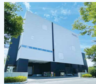
「マイルドクレンジング オイル」の新工場
